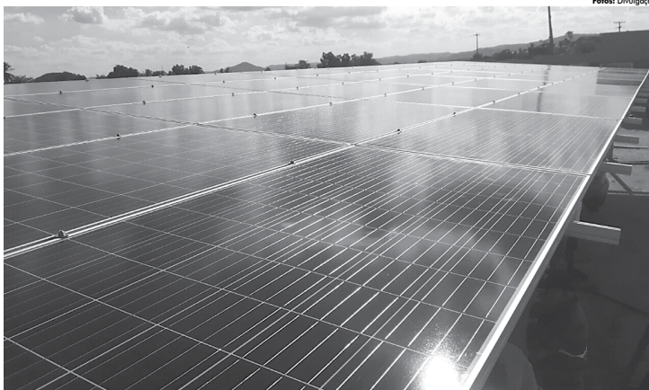
Sistema que utiliza a energia solar tem boa eficiência comprovada e está sendo utilizado na construção de habitações populares e de forma coletiva.
